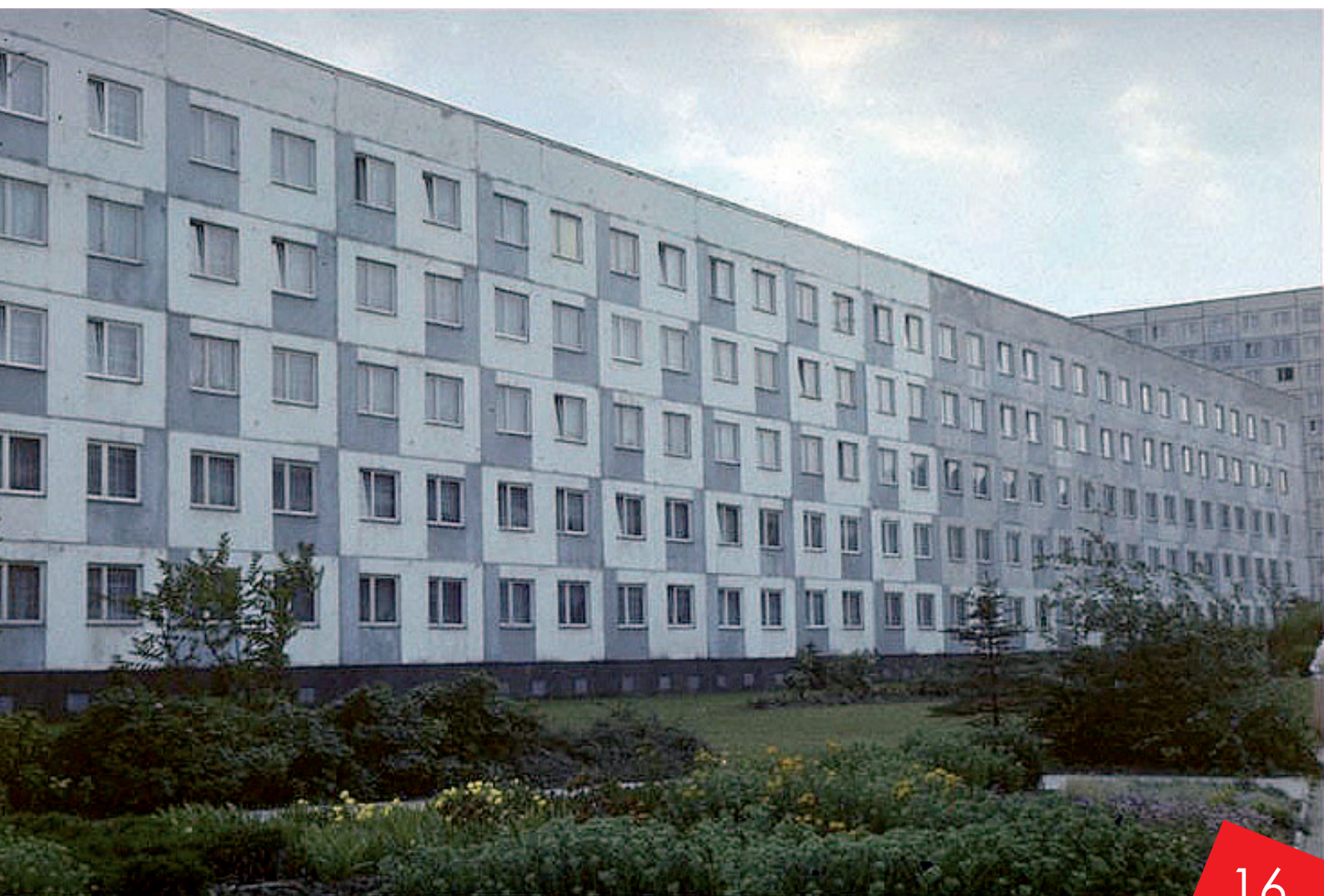
„Arbeiterschließfächer“ am Stadtrand – Plattenbausiedlung in Halle-Neustadt 1978
